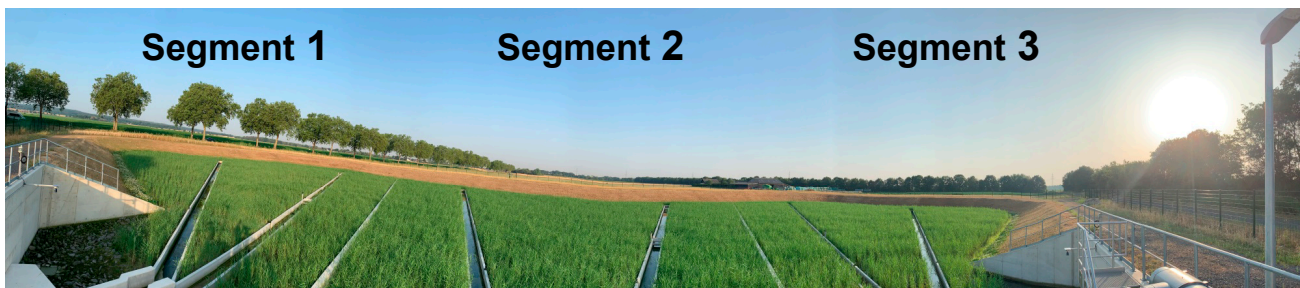
Abbildung 2: Aufbau der Filterkörper. Filtersegment 1 entspricht einem konventionellen RBF. Den Filtersegmenten 2 und 3 ist GAK beigemischt.
