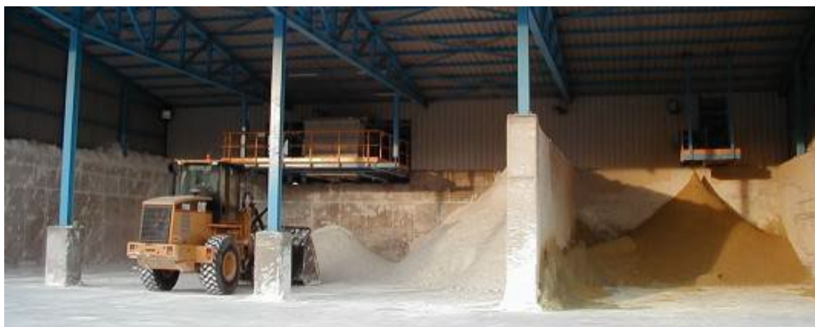
Abb. 6: Lager der Reststoffe aus der fraktionierten Fällung mittels Kalkmilch aus der Waschsäurebehandlung der Kupferhütte Atlantic Copper – links der Sekundärrohstoff technischer Gips, rechts der arsenkontaminierte Abfallgips. Quelle: A. Ante.
