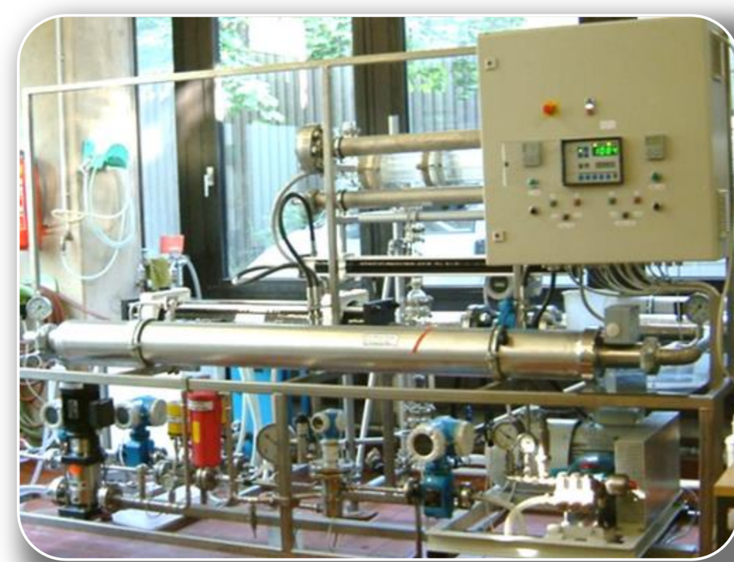
Abbildung 2: Pilotanlage für die HPRO und NF zum Testen von Spiralwickелеlementen (2,5" und 4")
