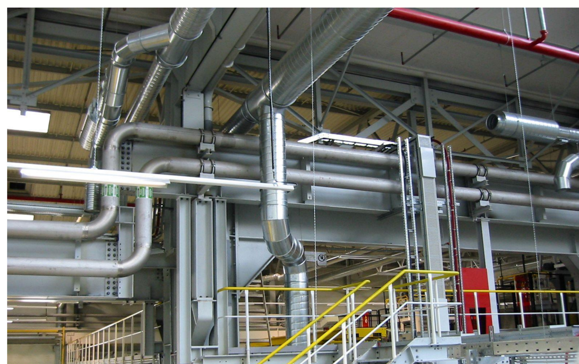
Abb. 3: Dynamisches Leitungsnetz als Basis des Water-Reuse in Industrieparks
