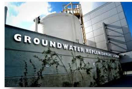
Groundwater Replenishment System, Kalifornien, USA
