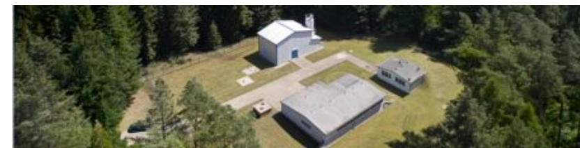
Wasserwerk Blockhaus [KWN]
