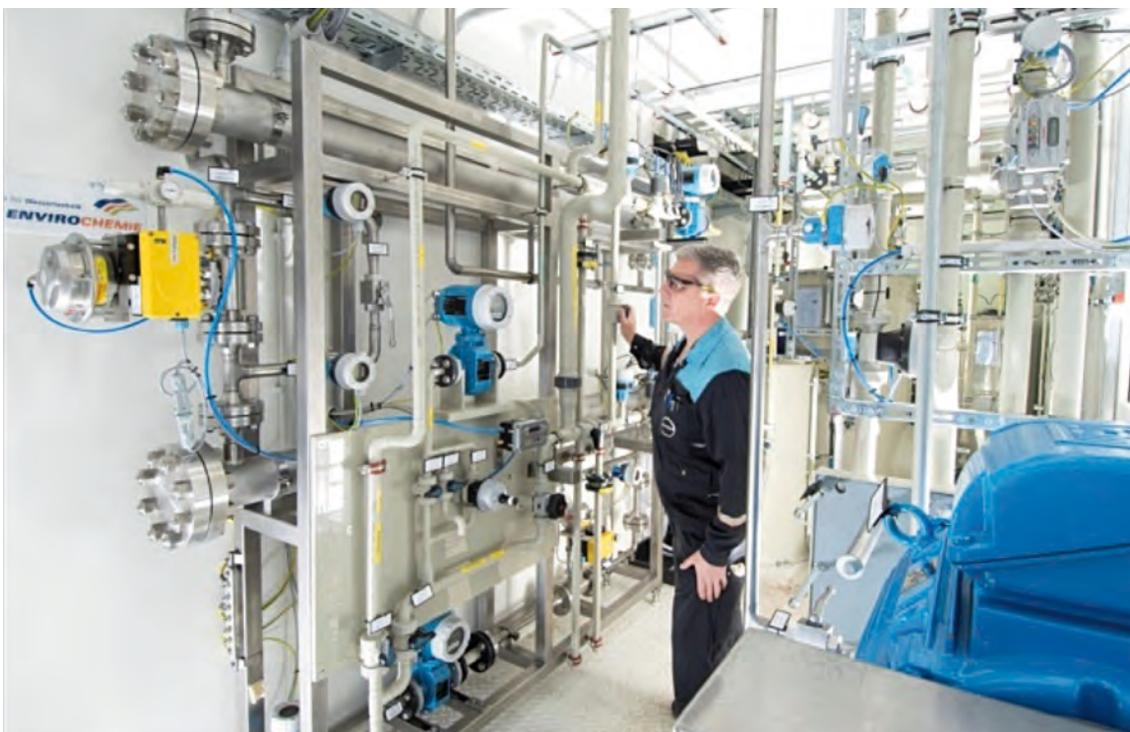
Abb. 26: Hochdruckumkehrosiose-Anlage für vier Spiralwickel-elemente
