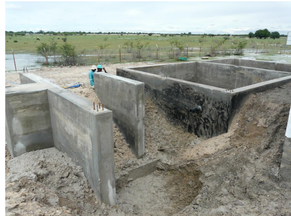
Abbildung 1: Bau der Vorbehandlung
