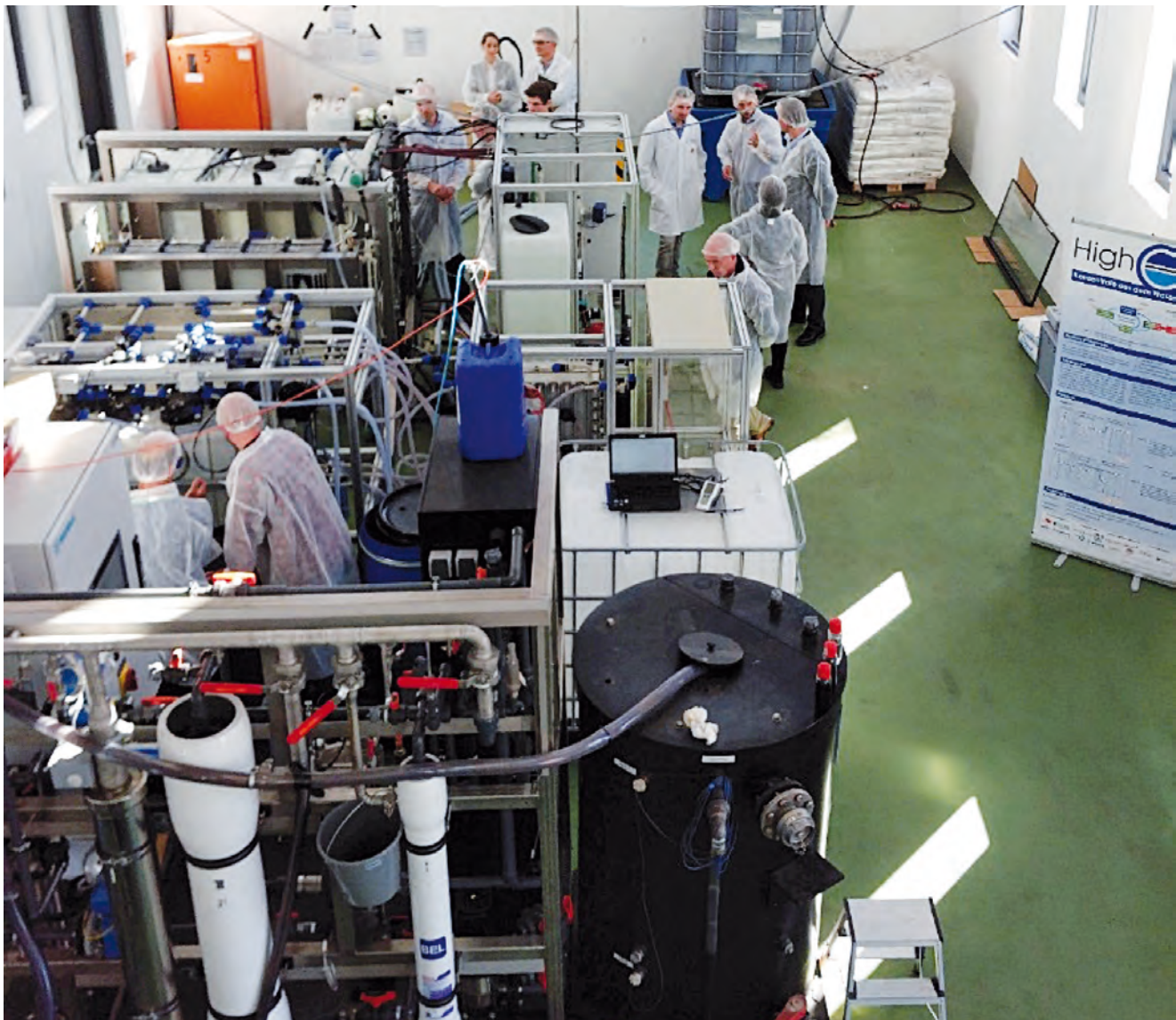
Abb. 27: HighCon Demonstrationsanlage am Standort der DEK Berlin mit folgenden Technologien (von vorne nach hinten): Nanofiltration, Elektrodialyse (Metathese) und Membrandestillation
