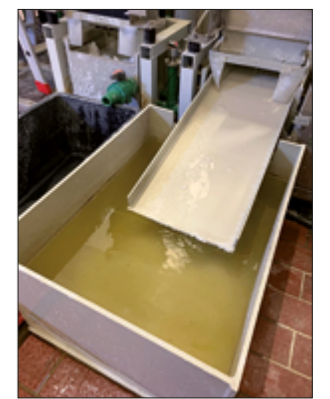
Abbildung 10: Rüttelkühlturm mit Setzbecken.
