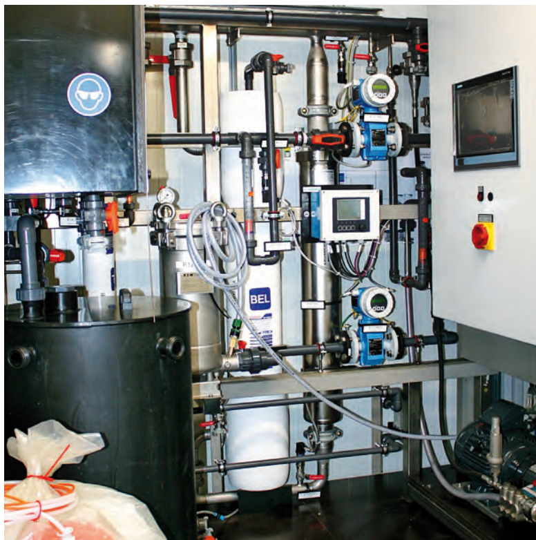
Abb. 20: Hochdruck-Umkehrosiose im Versuchscontainer
