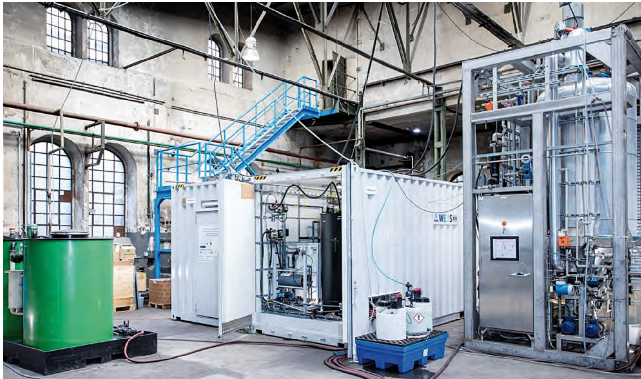
Abb. 19: Pilotanlage aus dem Projekt „WEISS“ zur Entsalzung von Kühlwasser (Foto: SMS group GmbH)
