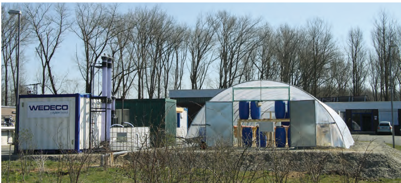
Abb. 5: Pilotierung in Hattorf: Blick auf die Abwasseraufbereitung (links) und das Gewächshaus (rechts) (TU Braunschweig, März 2017)
