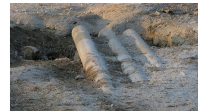
Abbildung 8. Flusswasserentnahmeverrichtung für das Frischwasser des Kraftwerkes in Esfahan (Quelle: A. Ante)
