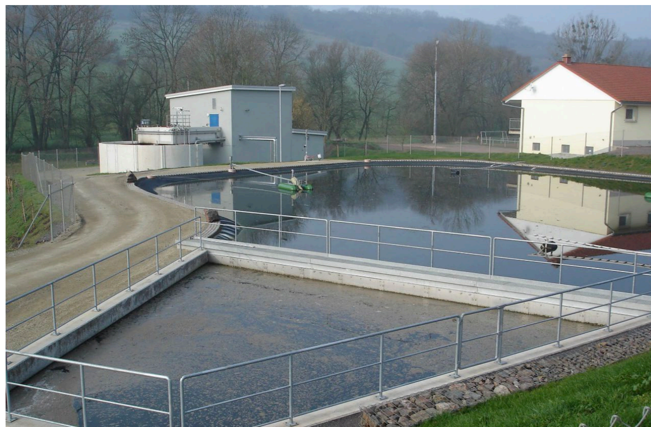
Abbildung 7. Gesamtansicht der LAGOON-MEMB Demonstrationsanlage – im Vordergrund die Anlagenstufe 1 (belüfteter Vorteich), im Hintergrund die Anlagenstufe 2 (Membranbelebung) mit dem zugehörigen Betriebsgebäude (Quelle: A. Ante)
