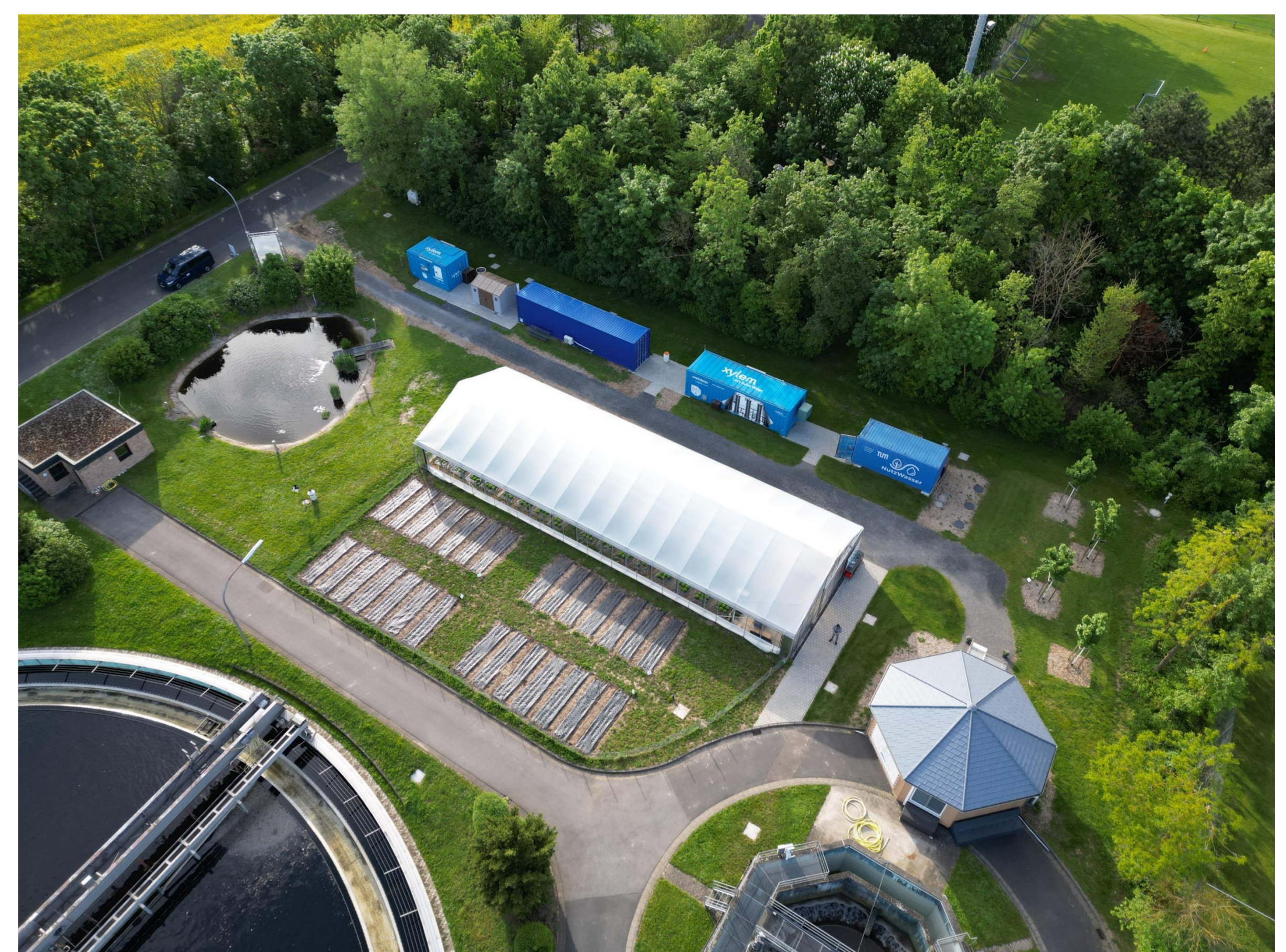
Bild 2: Pilotanlage zur Demonstration einer Wasserwiederverwendung im Projekt Nutzwasser
