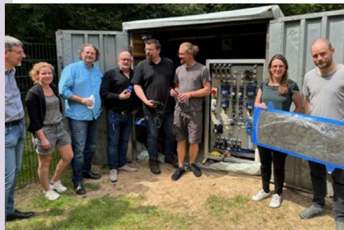
Projektpartner und Elektrode mit selektiver Anionenaustauschermembran und Spacer für selektiven Nitratrückhalt beim Kreisverband für Wasserwirtschaft Nienburg (Quelle: Joachim Oltmann, Kreisverband für Wasserwirtschaft Nienburg)
