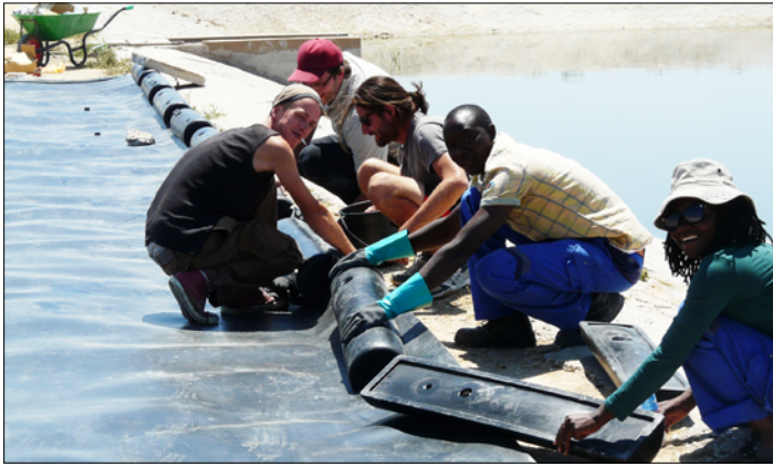
Abb. 6: Montage der Leitwände (Foto: Jochen Sinn, TU Darmstadt)
