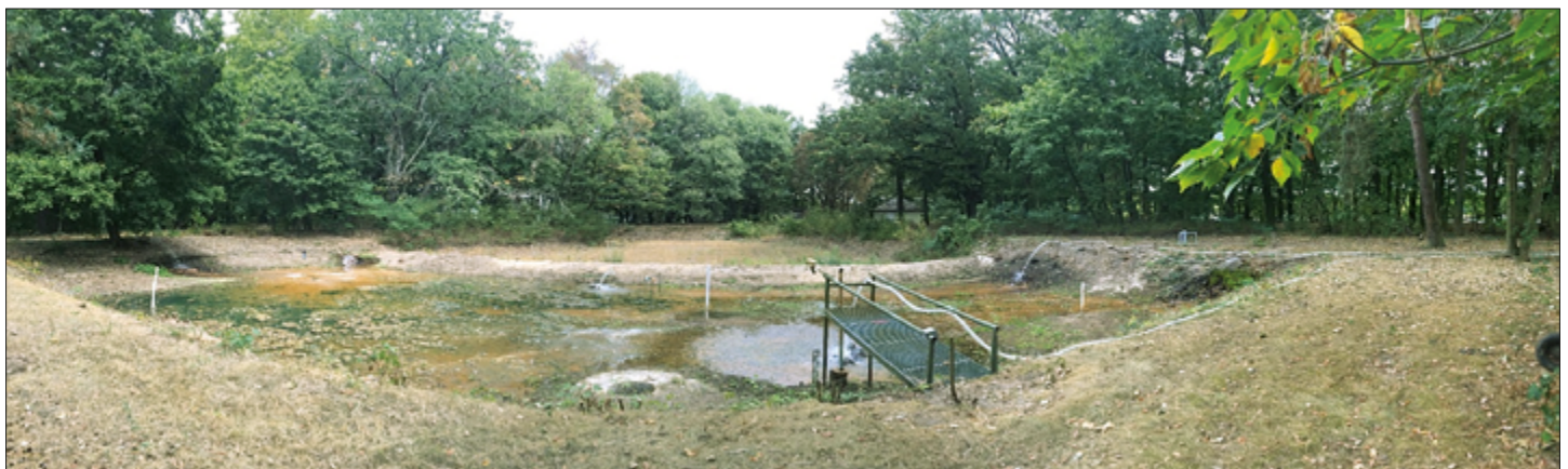
Abb. 6: Sequentielle Grundwasseranreicherung im Demonstrationsmaßstab am Standort Berlin-Tegel (Foto: Universität Oldenburg)
