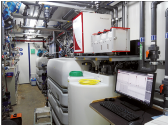
Abb. 2: Ansicht der Wasseraufbereitungsanlage des Projektes MULTI-ReUse in Nordenham mit installiertem Online Durchflusszytometer zur schnellen Quantifizierung von intakten und geschädigten Bakterien (Foto: IWW Zentrum Wasser)
