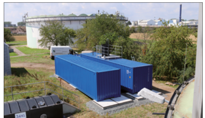
Abb. 4: Kopplung von Entsalzungsverfahren im elektrischen Feld und der aeroben biologischen Behandlung (links); Ansicht der gemeinsamen Pilotierung von der TU Darmstadt und der EnviroChemie GmbH auf dem Werksgelände des assoziierten Partners Merck KGaA (rechts)
